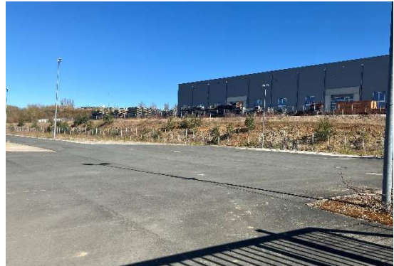
Abb. 4: Östliche Böschung mit Gehölzbestand
